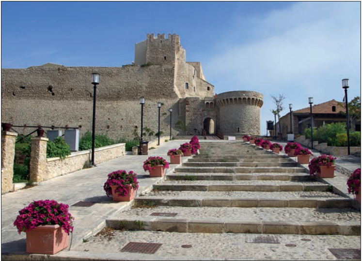
Isola di San Nicola: Treppenaufgang zur Chiesa Santa Maria a Mare
